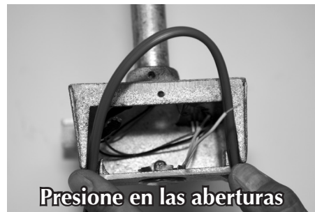
Entrada Lateral. Para el cable del tubo superior, forme un lazo y presione en las aberturas laterales inferiores.
