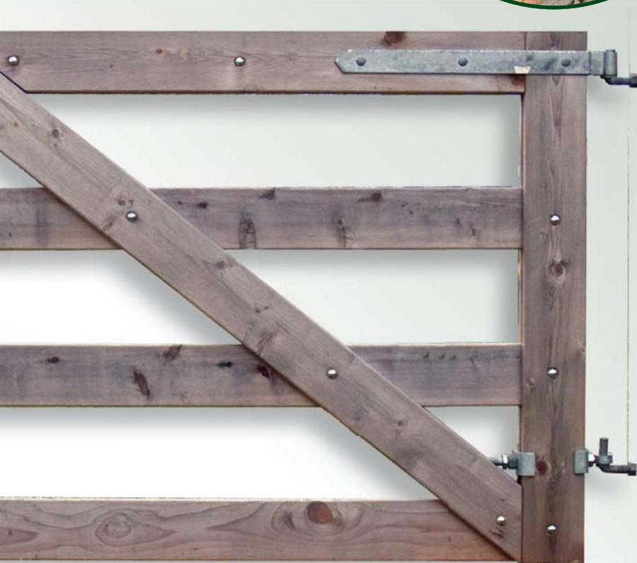
SPACES BETWEEN GATE AND POST AT EACH HINGE END.
